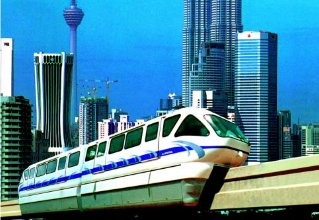
Monorail Malaysia (akan siap pada tahun 2001/to be completed in year 2001)
