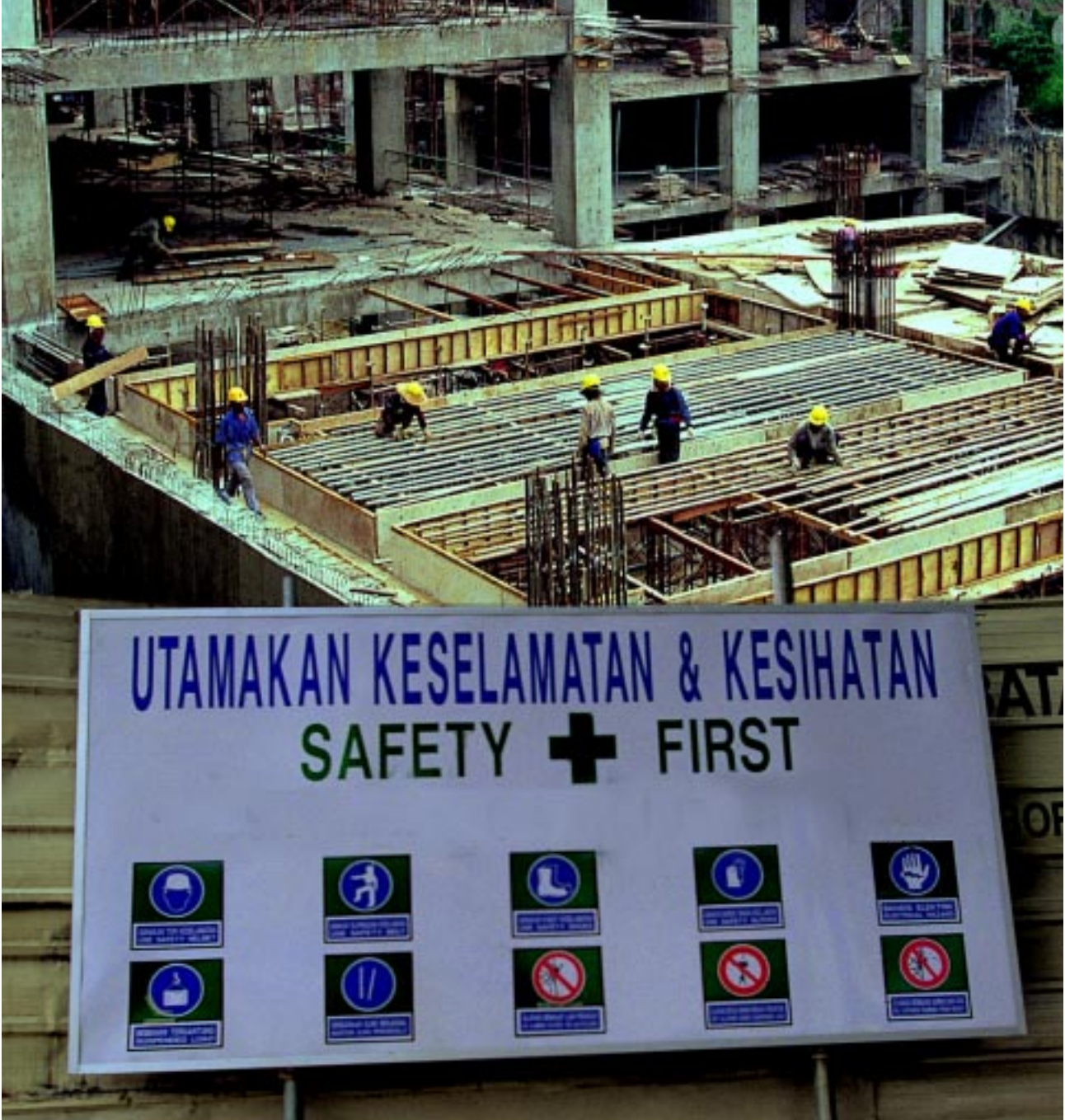
Tapak Pembinaan (Construction Site)
