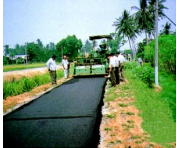
Menaiktaraf Jalan Kampung (Rural Road Upgrading)
