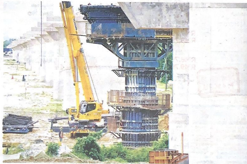
PROJEK ECRL yang sedang dibangunkan kini tetap berjalan seperti biasa dan tidak terlibat dengan penangguhan kerajaan. – GAMBAR HIASAN
