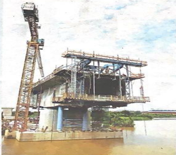
PEMBINAAN rel Jambatan Super Utama Sungai Kuantan bagi kegunaan ECRL di Kampung Padang, Kuantan.
